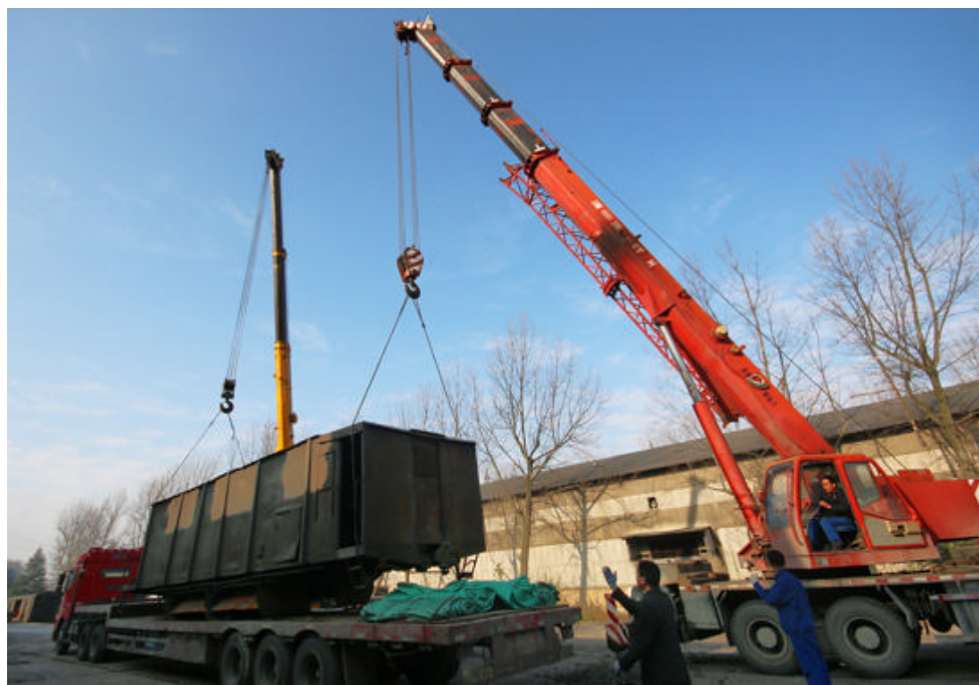
▲近日,由贵州贵铝物流有限公司负责储存的贵州高铁施工单位部分物资经该公司中转后转运至高铁施工现场。截至目前,该公司共完成此类车皮的吊装作业一百余车。图为该公司员工正在进行吊装作业。
